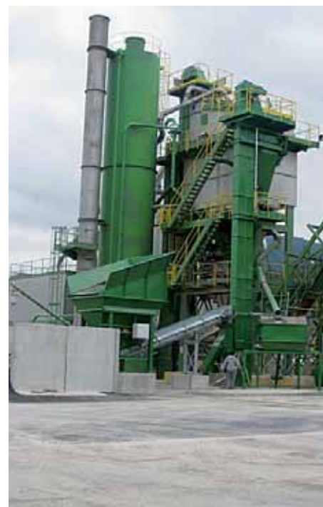
Slika 2. Asfaltno postrojenje tvrtke Cesta Varaždin d.d. dograćeno da omogućava dodavanje starog asfalta pri proizvodnji novih mješavina
