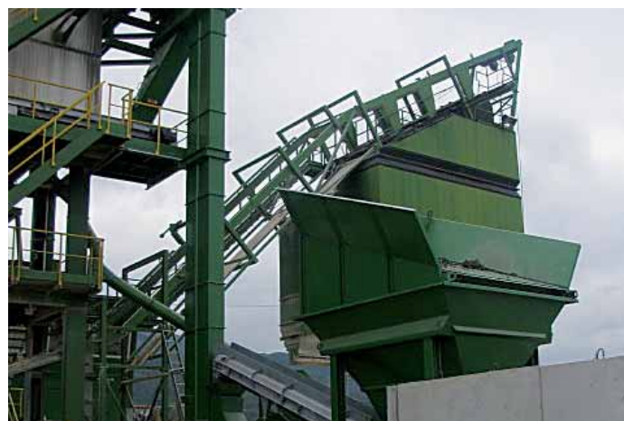
Slika 7. Događeni dio za dodavanje reciklažnog asfaltnog agregata
