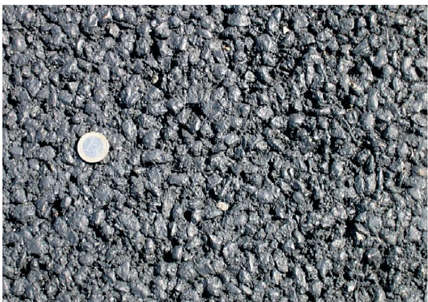
Slika 4. Makro-tekstura površine kolnika izvedene vrlo tankim slojem asfalta – Rugovia TM
