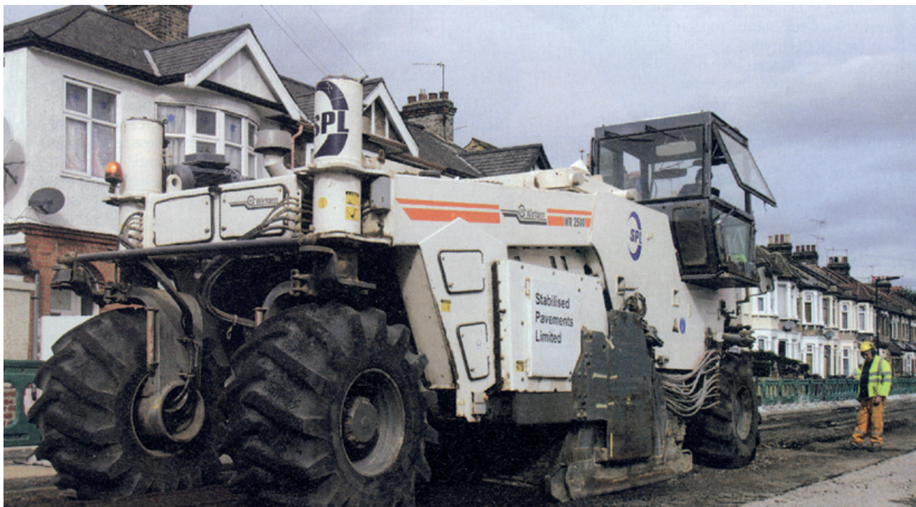
Za in situ recikliranje ulice u Newham-u korišten je 500kW Wirtgenov recikler WR2500 za usitnjavanje oštećenog kolnika do potrebne dubine 250mm
