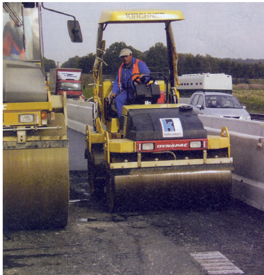
Učinkovito zbijanje ima ključnu ulogu u postupku istovremene ugradnje dva asfaltna sloja
