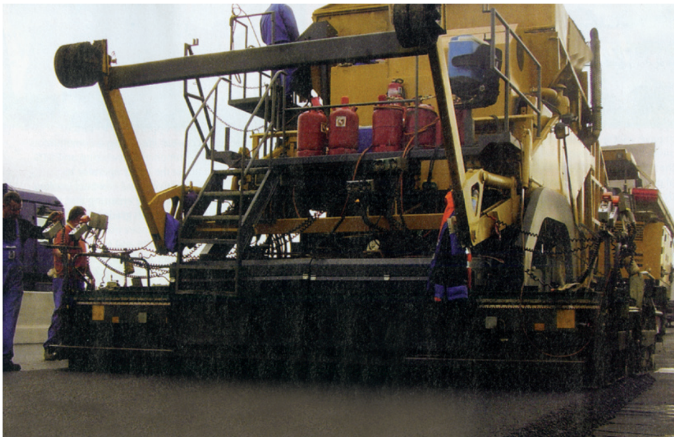
Sustav tvrtke Dynapac koristi modificirani finiše s dvostrukim sklopom za ugradnju asfalta dok tvrtka Voegelé sustav koristi dva prilagođena finišera
